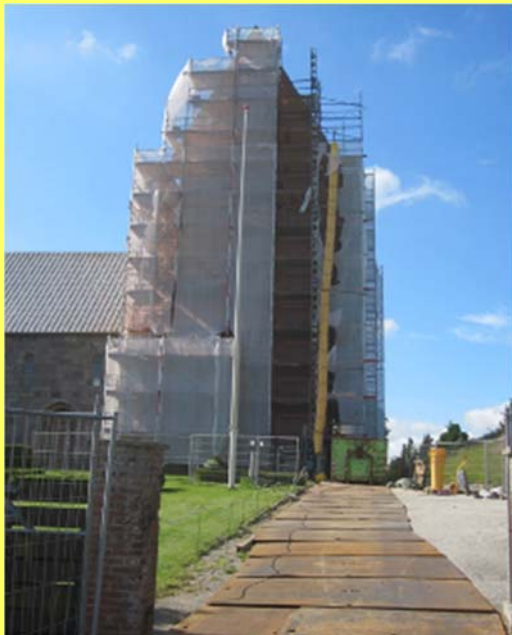
Til venstre ses det tildækkede kirketårn under ombygningen. (Foto Hans Lund)
