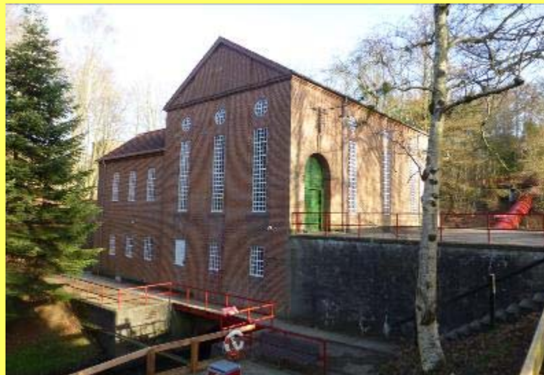
Den gamle turbinesal på Harteværket.
